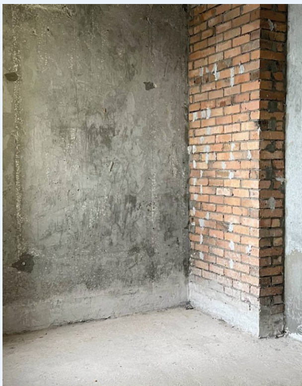
Помещение до работы команды RELI
