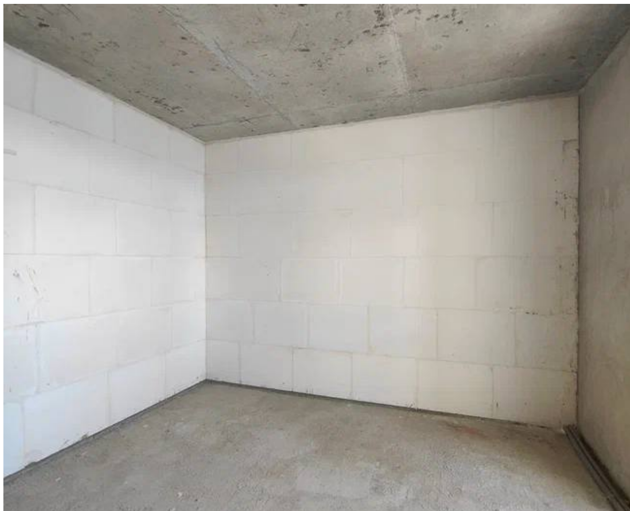
Склад для садового инвентаря до работы команды RELI
